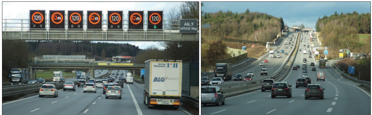
Abbildungen 11-12: Digitales Testfeld A9 München-Nürnberg für Platooning und probeweise geöffnetem Abstellstreifen (Fotos: Dörr, ein Freitag im Dezember 2017)
