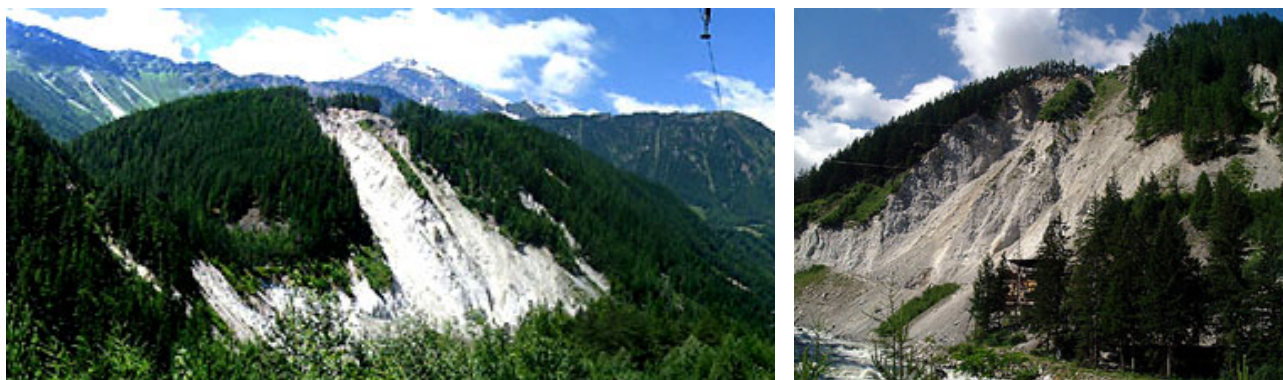
Abb.1: Lockergesteinsabbau Kitzwald (Blick von Südosten und Blick von Norden)
